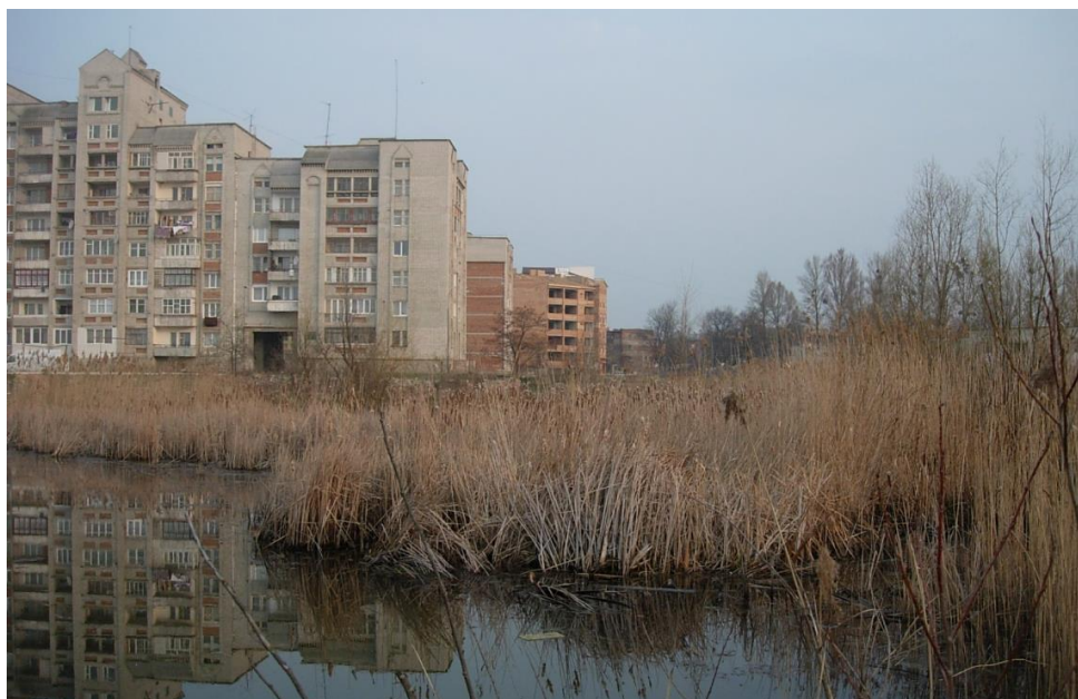
Рис.4.9 Підтоплена багатоповерхова житлова забудова на півночі міста
